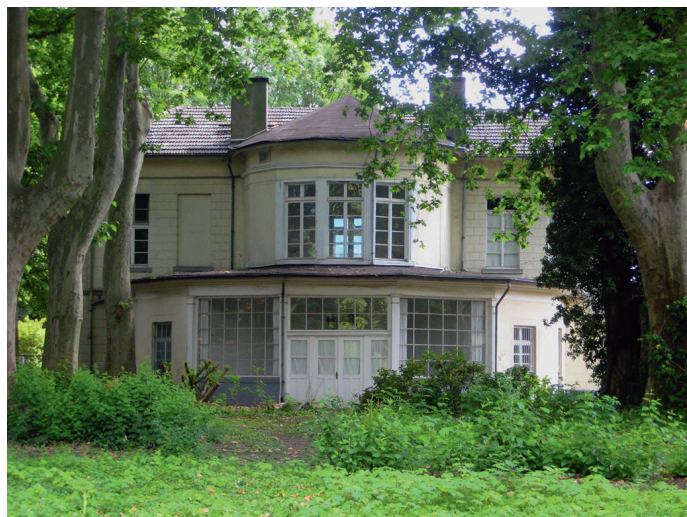
M 11 | Gartenseite des Bahnhof Belvedere in Köln-Müngersdorf. Er ist das letzte noch erhaltene Gebäude des ersten „Eisernen Rheins“. Foto: Förderkreis Bahnhof Belvedere e.V.
