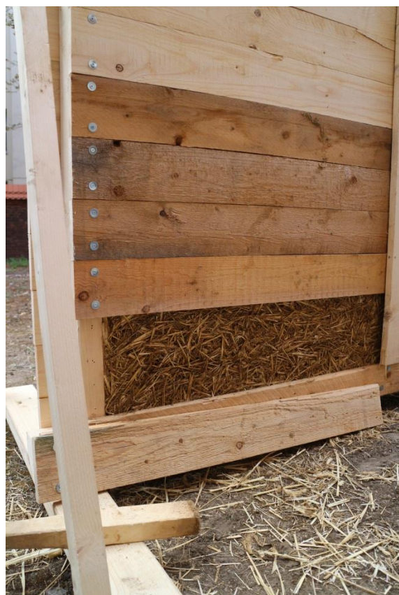
Vorbereitung der Strohwand durch Durchmischen der Bestandteile Lehm und Stroh
