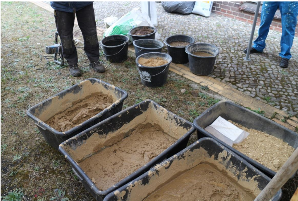
Anmischen des Lehmputzes
