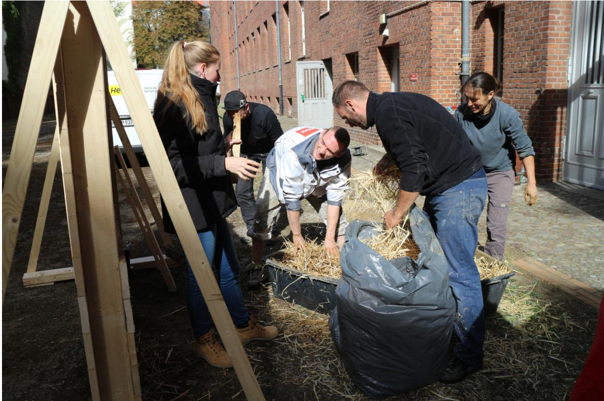
Vorbereitung der Strohwand durch Durchmischen der Bestandteile Lehm und Stroh
