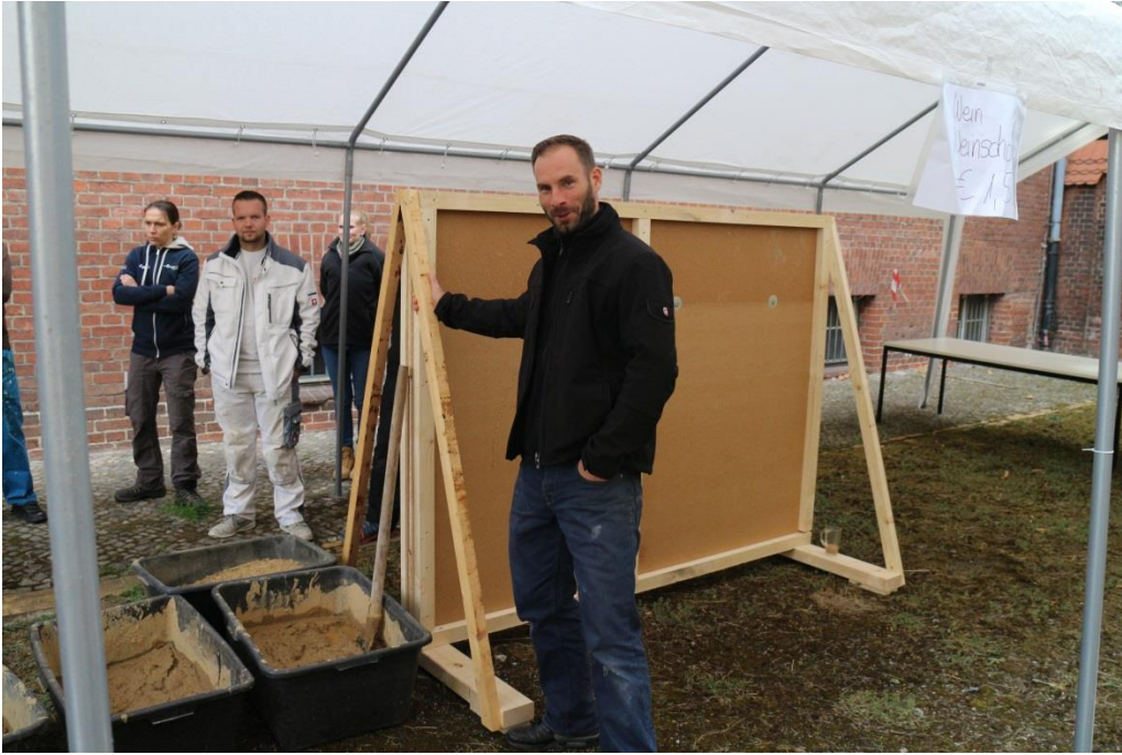
Herstellung eines Lehmputzes
