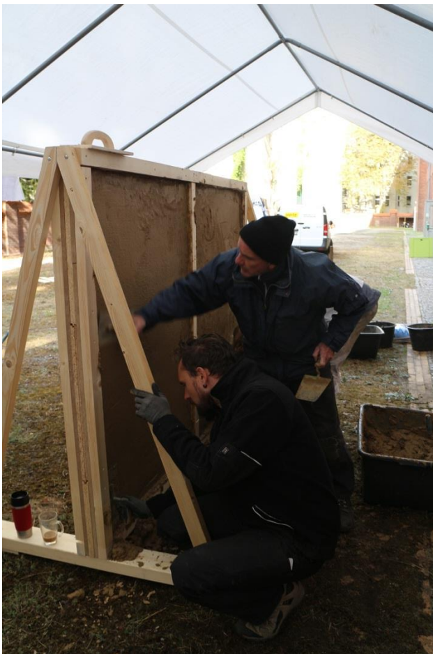
Aufbringen der Lehmputzmischung auf die vorgehässste Wand
