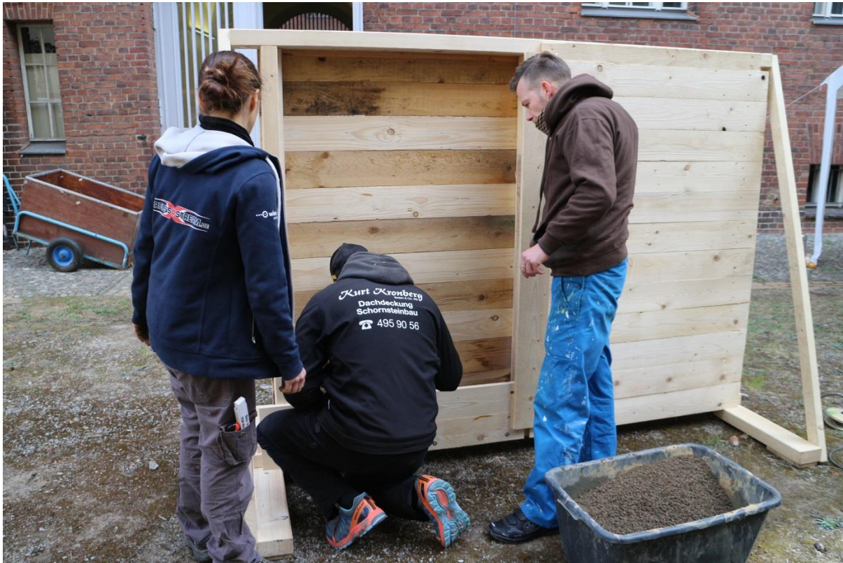
Vorbereitung der Schalung für die Strohwand
