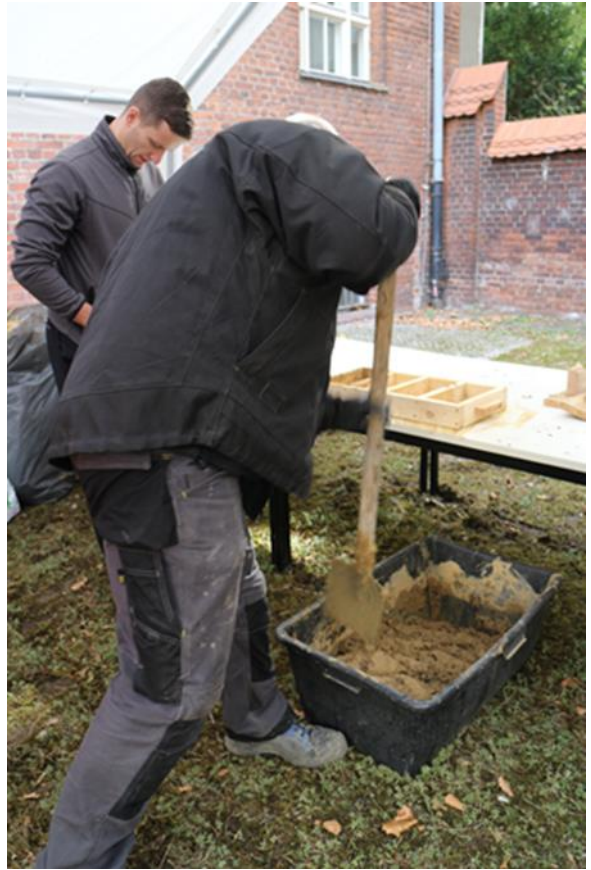
Vorbereitung des Untergrundes und Durchmischen des Putzes
