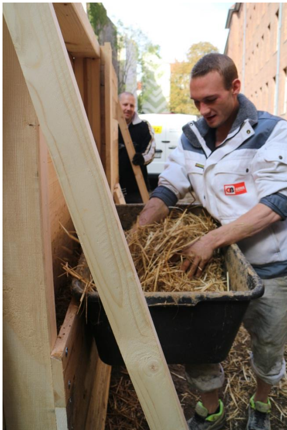
Vorbereitung der Strohwand durch Durchmischen der Bestandteile Lehm und Stroh
