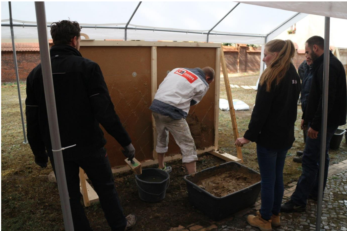
Vorbereitung des Wanduntergrundes für das Aufbringen des Lehmputzes
