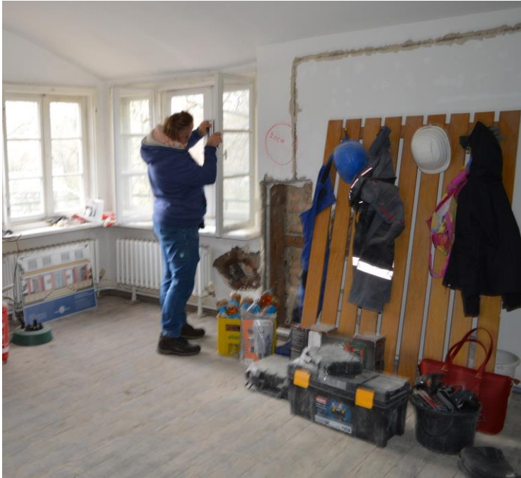
Aufmaß der Fensterprofile (IST-Zustand) der Doppelkastenfenster im 1. OG
