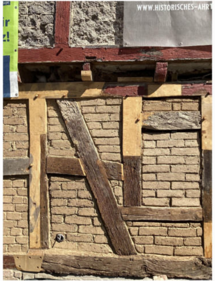
Gefach aus Lehmziegeln
