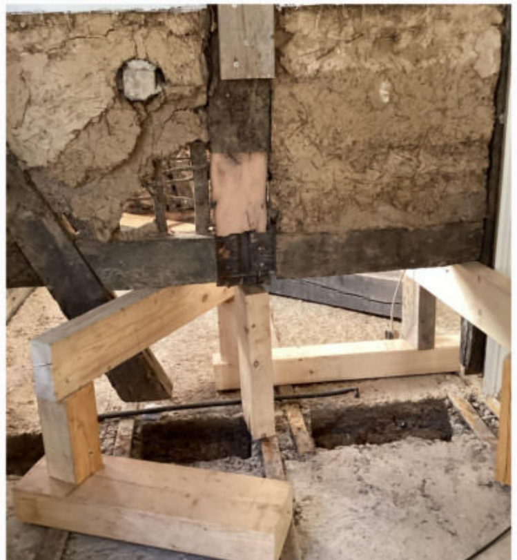
Abgestützte Holzbalken, (Ahrweiler)
