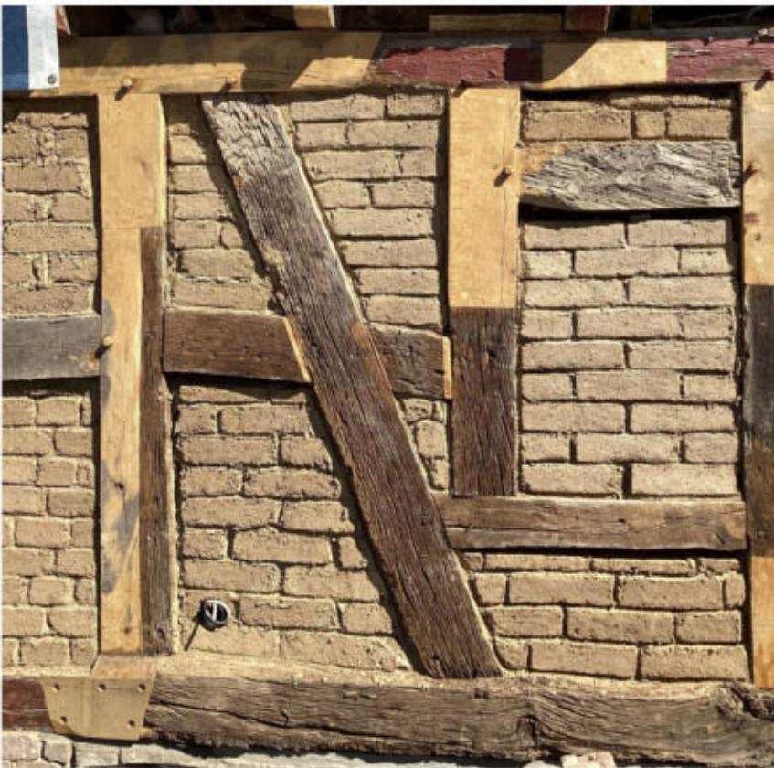
Restauriertes Gefache und Balken (Ahrweiler)
