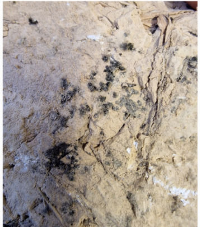
Lehmbewurf mit Schimmel (oberflächlich)
