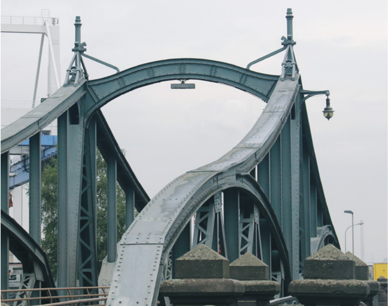
Die Krefelder Drehbrücke – Gegenstand eines denkmal aktiv-Projekts an der Gesamtschule Uerdingen im Schuljahr 2014/15.
