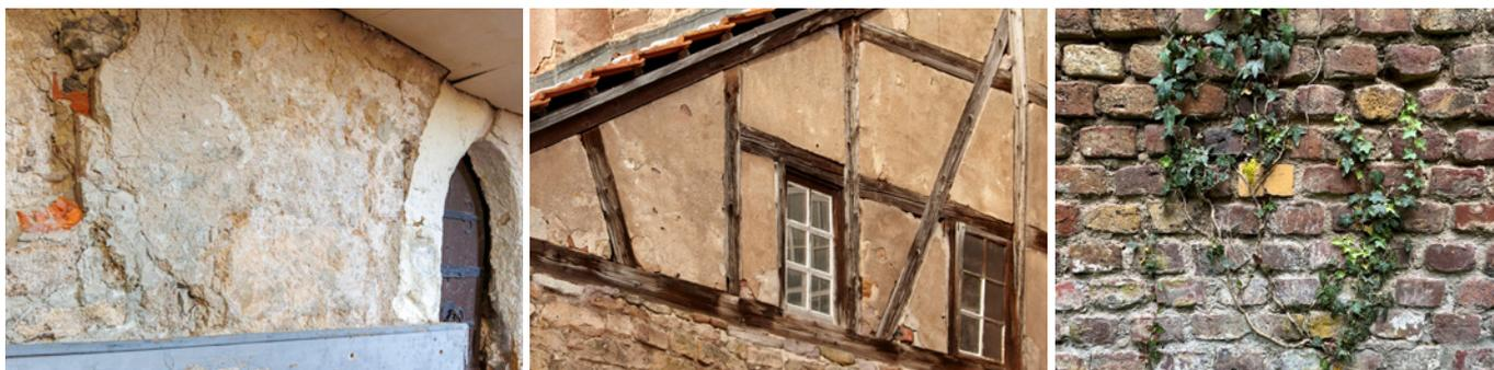
Schäden am Innenputz einer Kirche, an den Gefachen und Hölzern einer Fachwerkfassade, den Fugen und Steinen einer Backsteinmauer
