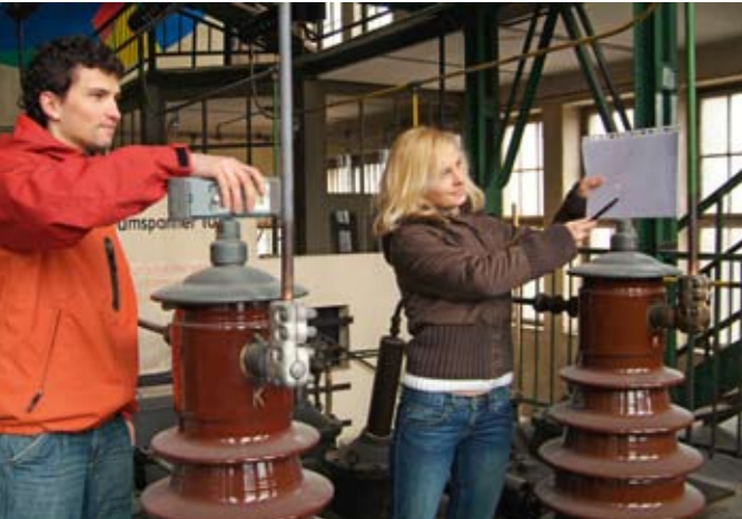
Das ehemalige Umspannwerk Jena-Nord wurde 2006 von Schülern des Staatlichen Berufsbildenden Schulzentrums Jena-Göschwitz erkundet.
