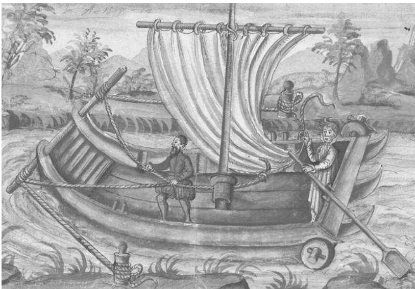
Arbeitsboot zur Flussvertiefung (aquarellierte Zeichnung, um 1575) Abb.: Landeshauptarchiv Sachsen-Anhalt, Abt. Magdeburg, Rep. Cop. Amtsbücher, Nr. 803b
