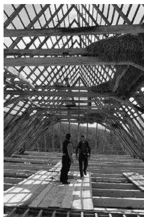
Die Instandsetzung von historischen Dachkonstruktionen gehört zum Aufgabenfeld des Restaurators im Zimmerhandwerk.
